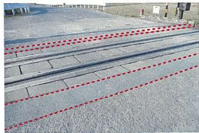
踏切の段差修正に 施工後5年
