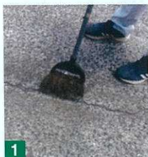
1 施工箇所を清掃
